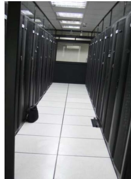
PUE：資料中心總耗電/IT設備總耗電
