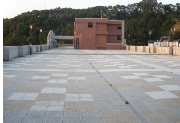
產學大樓頂樓雨水收集區
