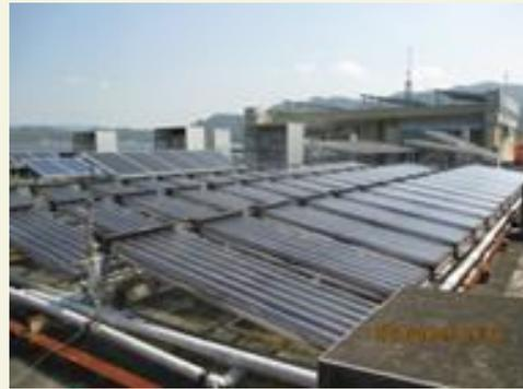
工程館頂樓建置熱能發電系統，利用太陽光之紫外線照射電熱系統，由熱能轉換電能發電。
