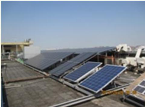
工程館頂樓建置太陽能發電系統，將電能儲存後，於尖峰用電時間供應該棟使用。
